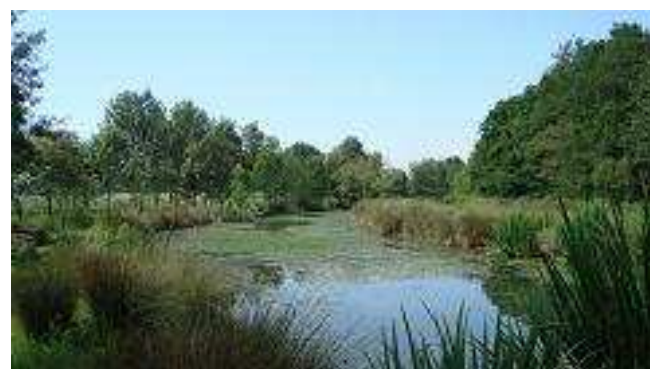
Les bassins de lagunage
